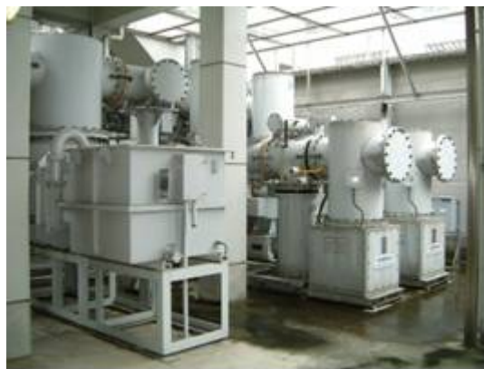
ガス絶縁開閉装置 (GIS) (SF 6 内蔵)
