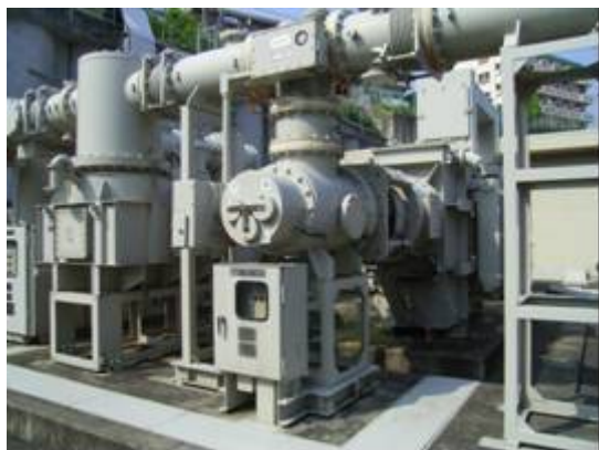
ガス絶縁開閉装置 (GIS) (SF 6 内蔵)
