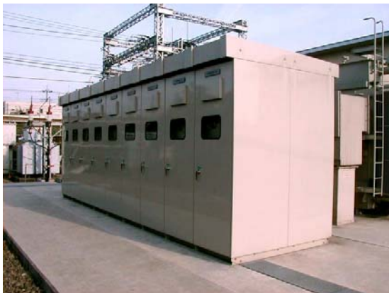
キュービクル形ガス絶縁開閉装置（C-GIS）（SF 6 内蔵）
