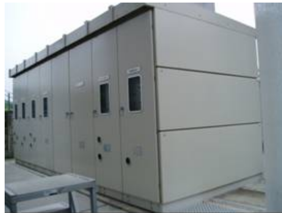
キュービクル形ガス絶縁開閉装置（C-GIS）（SF 6 内蔵）
