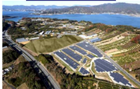
太陽光発電所
