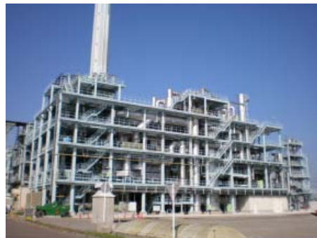
東京都東部スラッジプラント汚泥炭化施設
