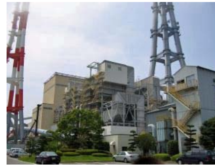
常磐共同火力発電所発電施設
