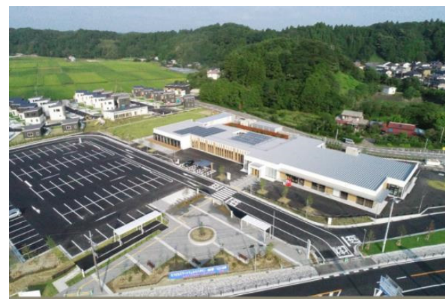
むつざわスマートウェルネスタウン （手前が道の駅むつざわつどの郷、奥が住宅エリア）
