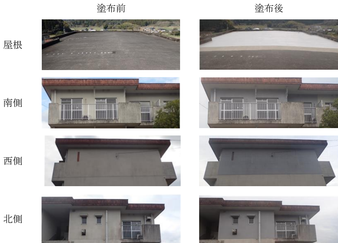
図 II-3-2-5 実証住宅試験施工塗布前後の写真
