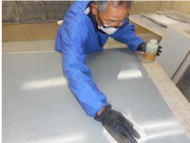
図 168 鋼板への離型処理
