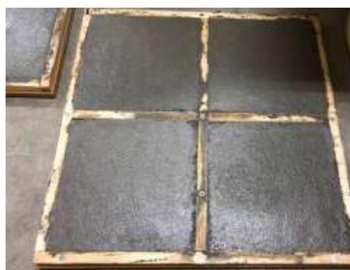
図 156 型枠への打設
