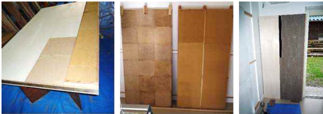
図 35 外壁部品の作成・取付の様子
