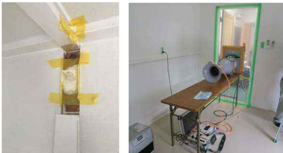
図 41 気密補修 (欠損部へのウレタン吹付充填) と気密測定の様子
