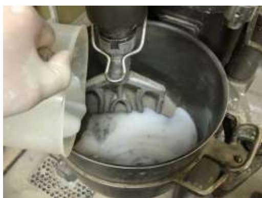
図 155 モルタルミキサによる混練
