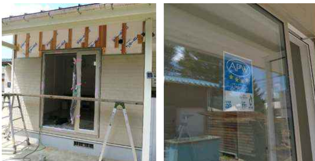
図 42 テストハウス両室の南側掃出し窓の交換 (高断熱化)
