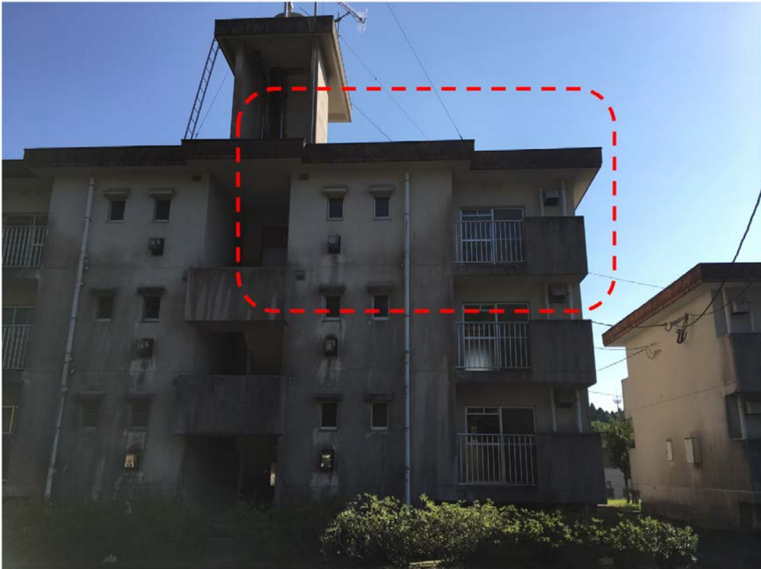
図Ⅱ-4-2-4 実験住宅北側外観
