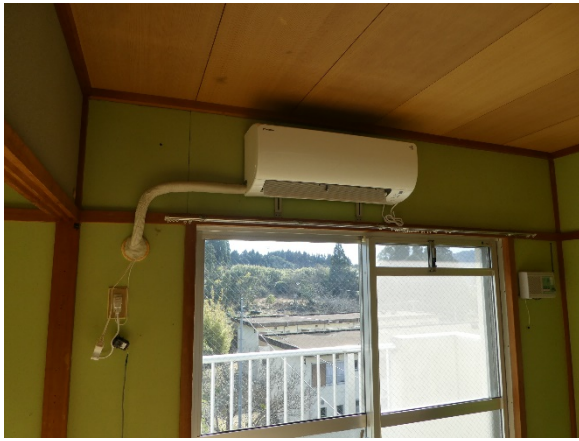
図Ⅱ-4-2-11 2号棟 231 室のエアコン消費電力量計測器設置の様子 (左：エアコンと CT、右：電力量計とパルス測定器)
