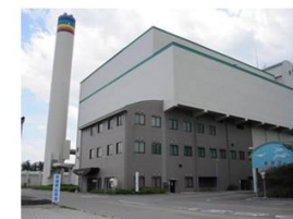
米子市クリーンセンター(4,000kW)
