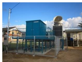
湯梨浜地熱発電所(20kW)
