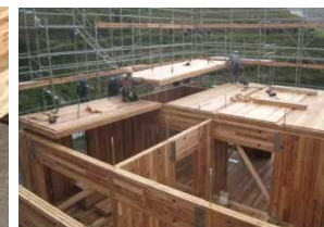
CLTを用いた施工例
