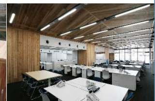
CLTを用いた施工例
