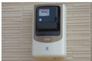
スマートメーター
