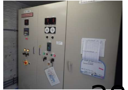
ポンプ制御盤 インバータ機器(5.5kW)
