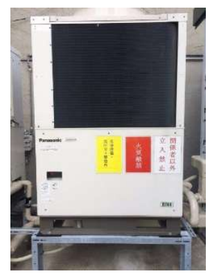
CO 2 冷凍 (室外機)
