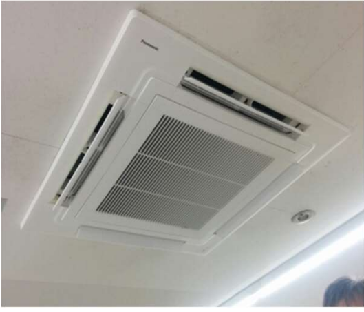
高効率空調設備 (室内機)
