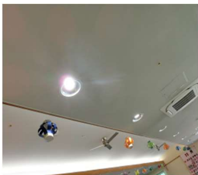
共用部分の照明と空調
