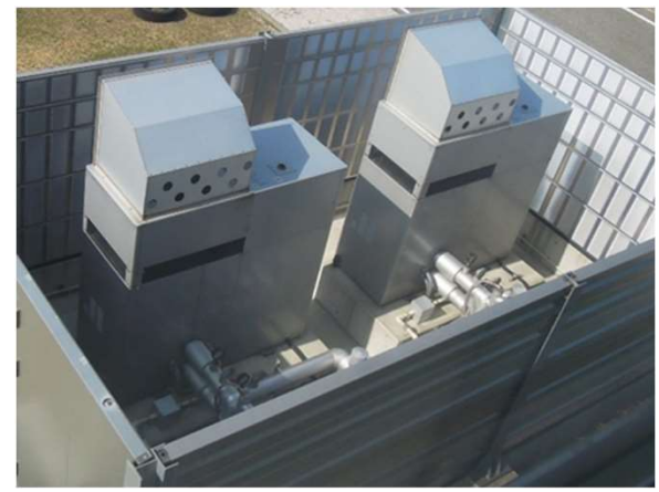
コージェネレーション設備
