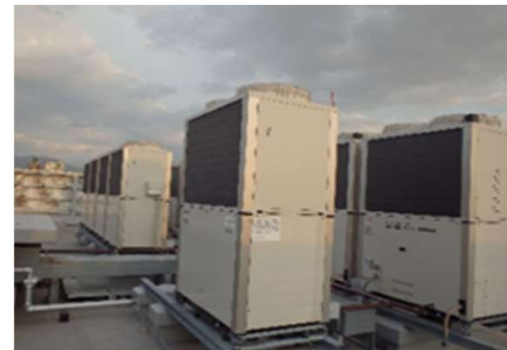
ガスヒートポンプエアコン
