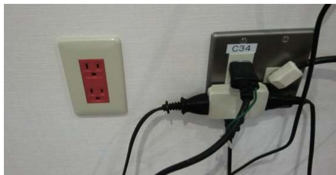
非常用の赤いコンセント
