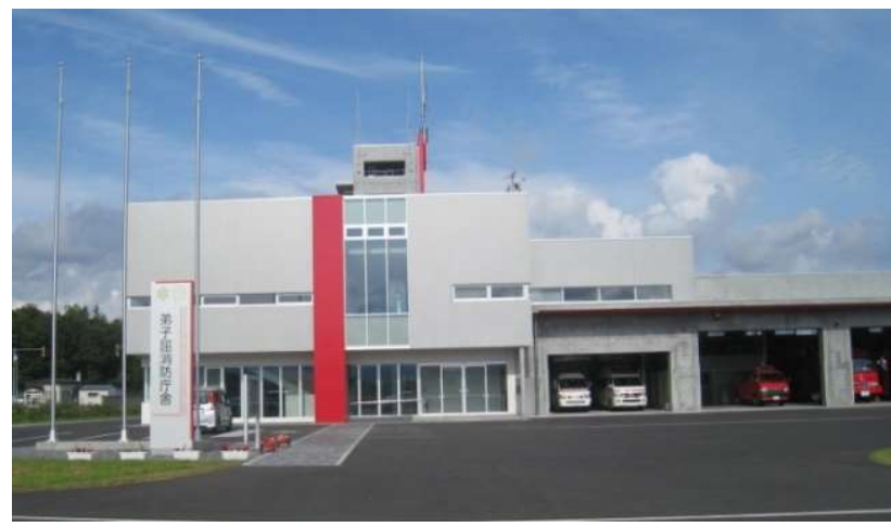
弟子屈消防署 全景
