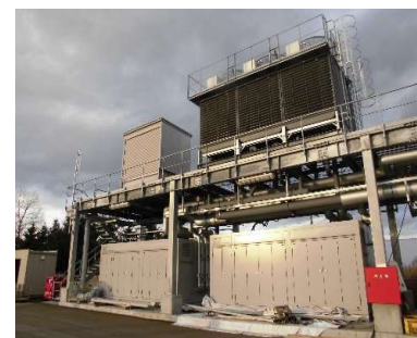
屋外での機器設置状況 下段に冷凍ユニット、架台上段に冷却塔や除害装置を設置。
