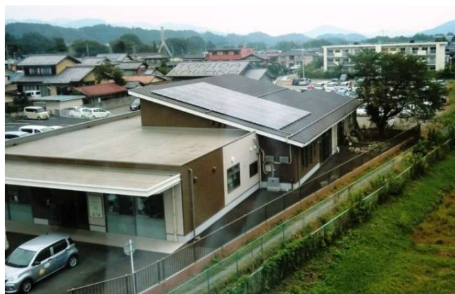
施設全景・太陽光パネル
