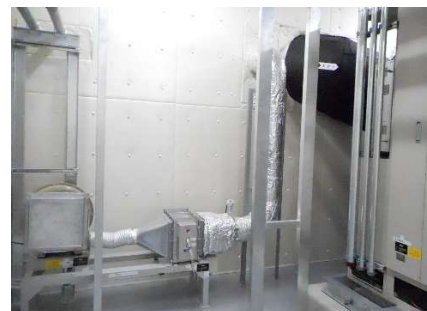
ダクト・ダクト霜取ヒーターユニット。 超低温空気を倉庫内へ送るダクト配管。除霜ヒーターを内蔵。
