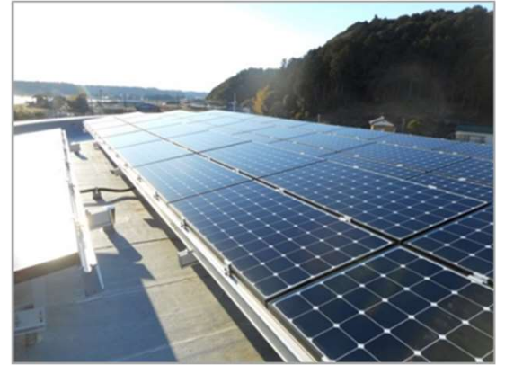
太陽光発電設備
