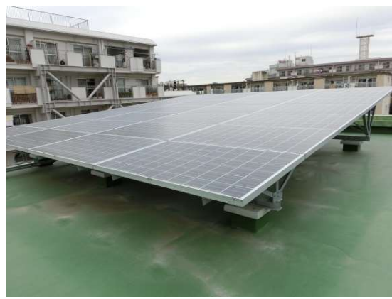
屋上に設置した太陽光発電パネル
