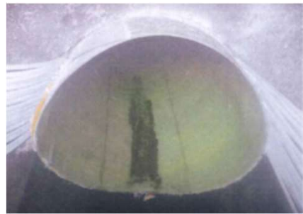
採熱施設 (下水管路内採熱管 L=65m)
