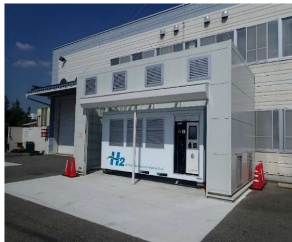
水素ステーション
