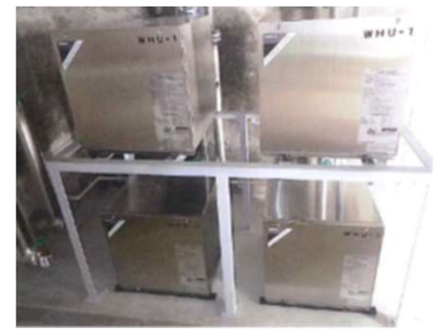
熱利用施設 (ヒートポンプ10kw×5台)
