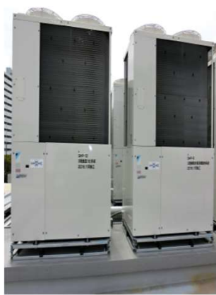
エアコン室外機
