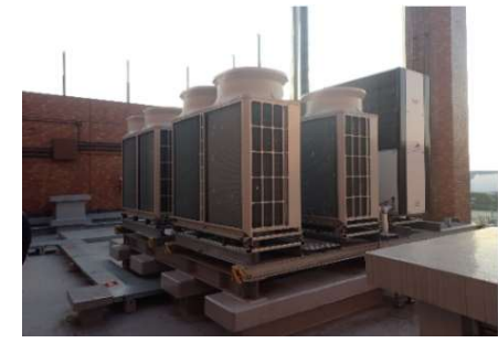
高効率空調設備
