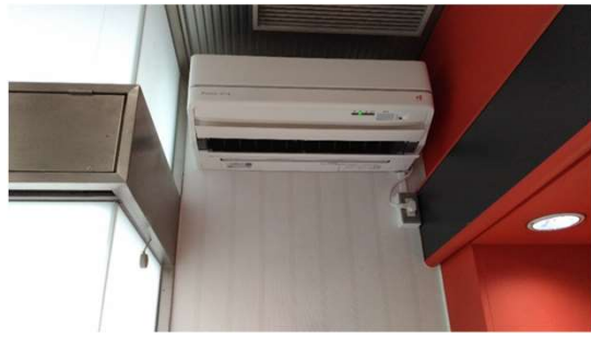
高効率空調設備
