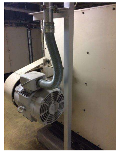
給気ファン(ダクト)
