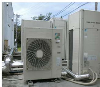
エアコン室外機
