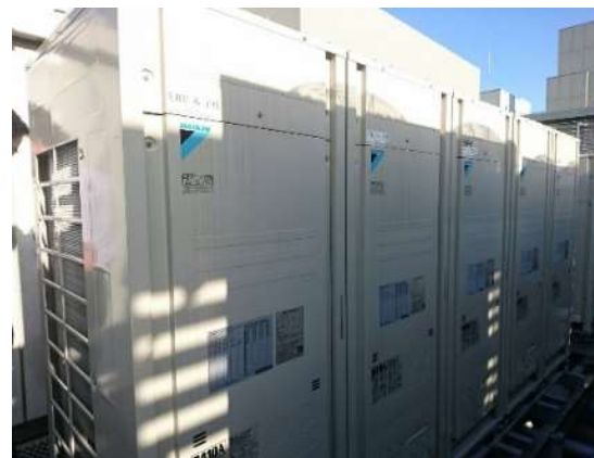
高効率空調(室外機)
