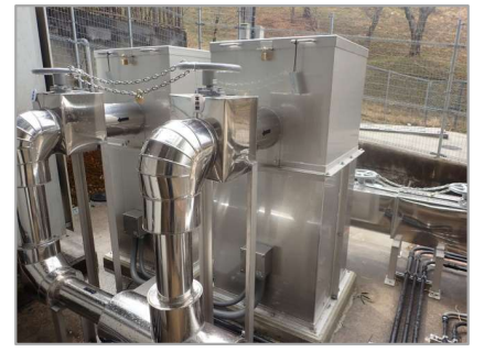
加圧ポンプ 1号(5.5kW)、2号(5.5kW)
