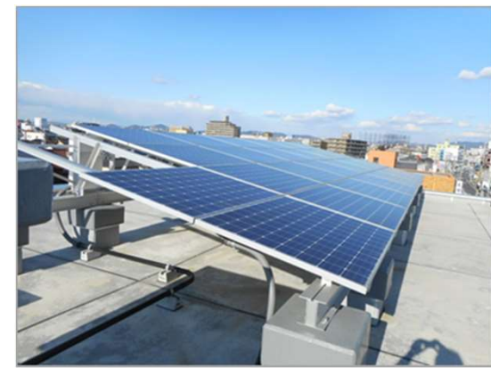
太陽光発電設備
