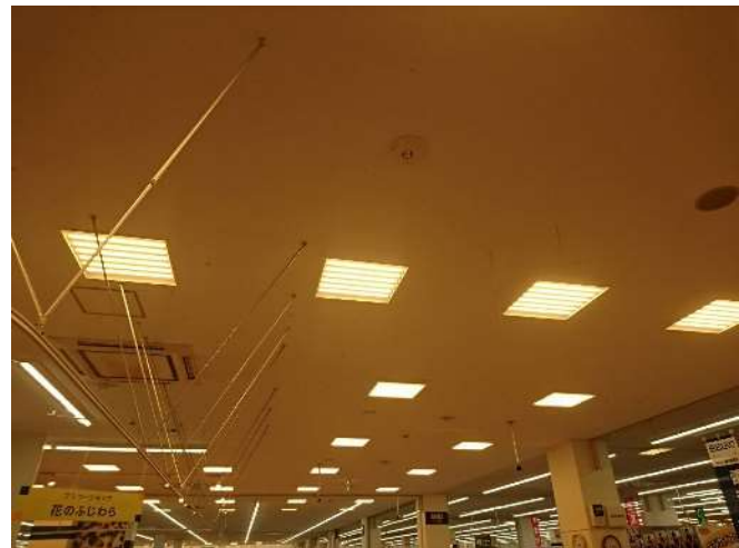
LED照明（室内）
