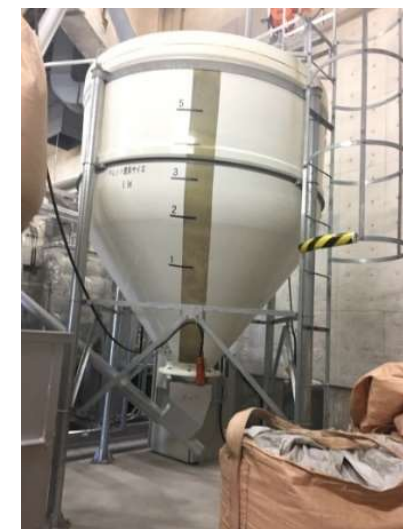
ペレットのストックヤード (サイロ)
