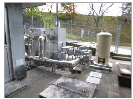
概観 左：加圧ポンプ2基 右：圧力タンク
