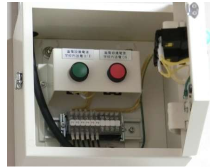
非常用系統切り替え用ボタン (用務員室)
