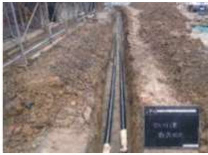
熱輸送施設 (熱輸送管 L=141m)
