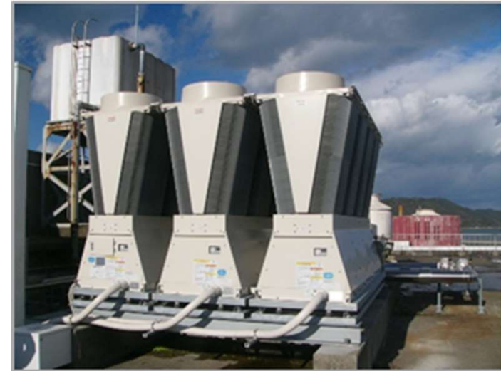
高効率空調設備（チリングユニット）
