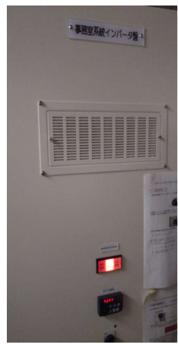
インバータ制御装置
