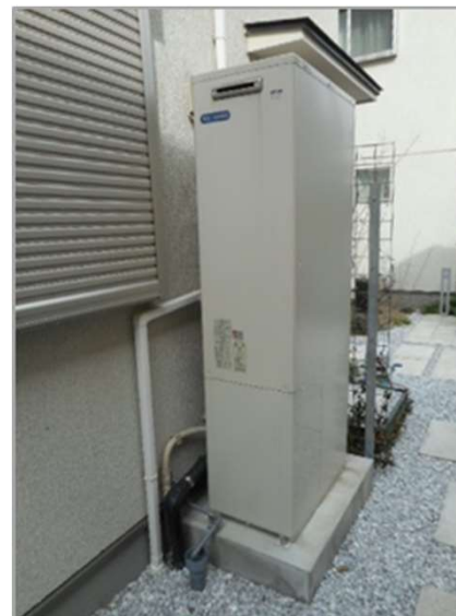
太陽熱利用ガス給湯システム
