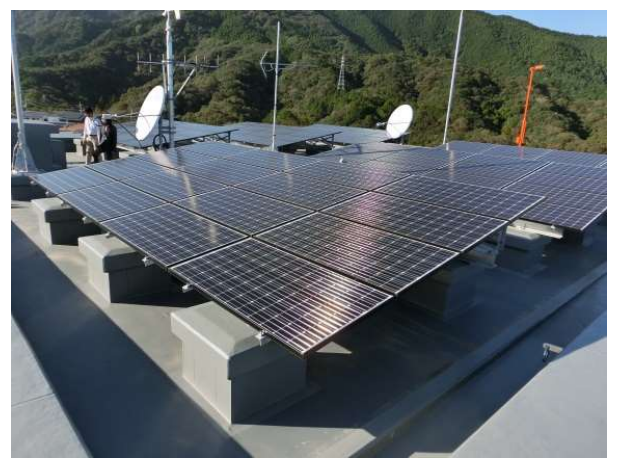
屋上に設置した太陽光発電パネル
