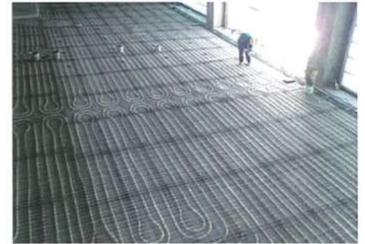
▲床暖房配管敷設(車庫)
