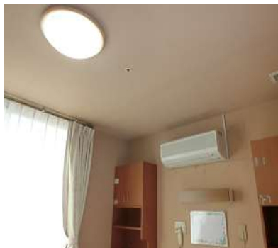
居室の照明と空調
