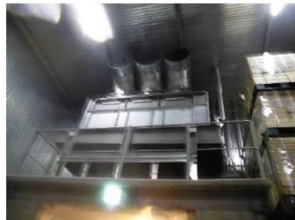
ユニットクーラー 架台上に設置し、冷気を対流させている。
