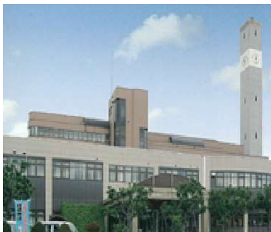
西清掃センター 外観
