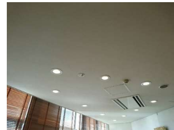
高効率空調(室内機)
