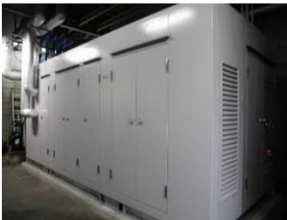
冷凍ユニット。機械室での設置状況。
