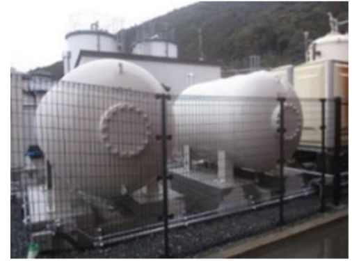
バッファタンク ×2基
