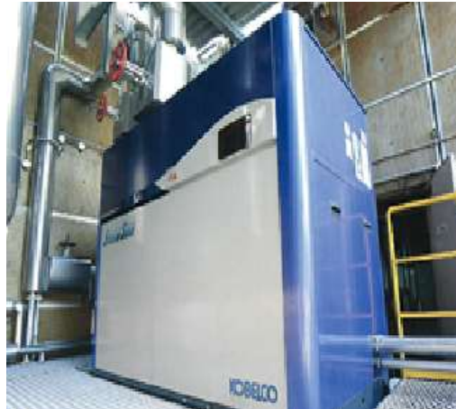
小型蒸気発電機の外観 (出典：坂戸市西清掃センターパンフレット)
