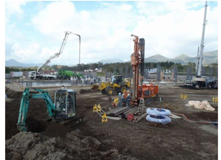
試験井掘削中
