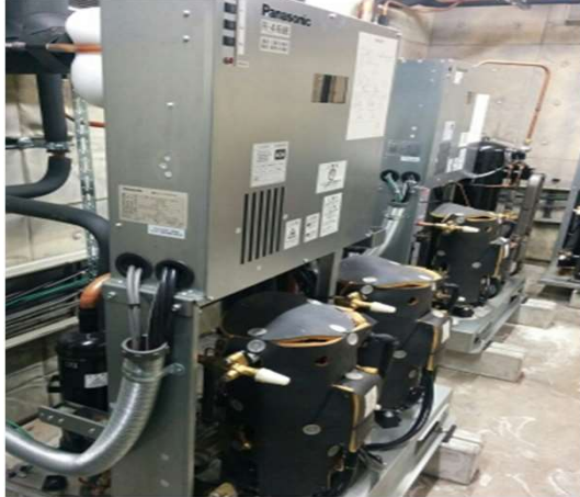
冷凍冷蔵設備
