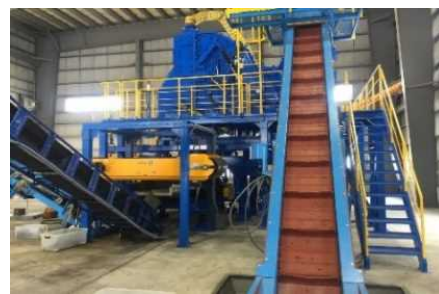
導入設備 (特殊高度破碎機)
