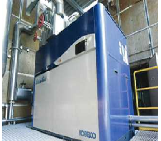
小型蒸気発電機の外観 (出典：坂戸市西清掃センターパンフレット)
