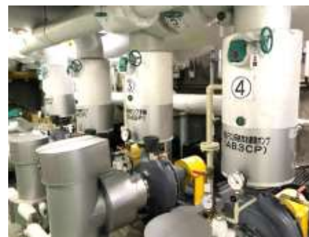
冷水・冷却水ポンプ
