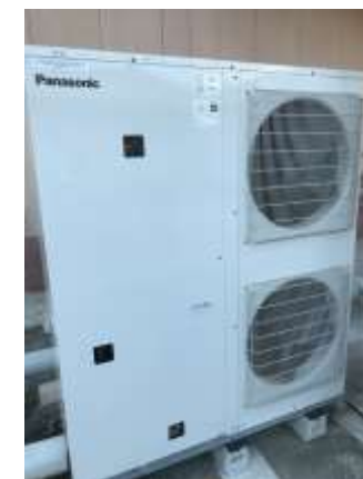
冷凍機（室外機）
