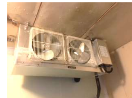
バックヤード冷凍冷蔵庫
