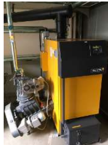
バイオマス（木質ペレット）ボイラー
