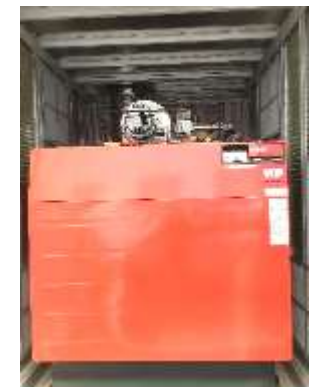
潜熱回収温水ヒーター（設備本体）
