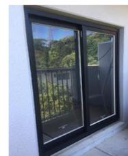
図 CNF 遮熱合わせガラス嵌め込み完了後の CNF 樹脂サッシ障子
