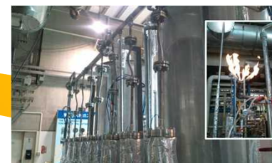
2010年 東京ガス 6 Nm 3 -CH 4 /h
