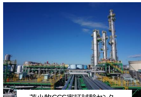
苫小牧CCS実証試験センター
