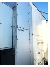
間接気化式冷温水気 (打5水の原理で室内の 冷却を行う設備)
