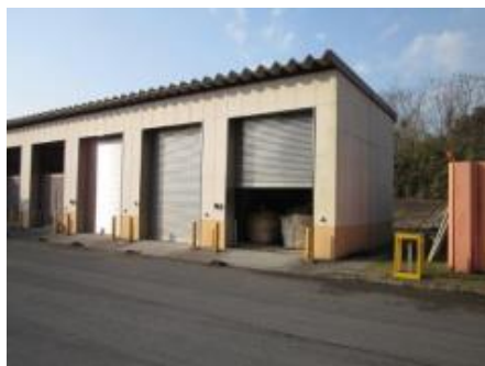
写真 2.4.1 保管庫の外観の例
