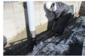
●側溝の汚泥の除去
