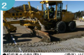
●表土の削り取り
