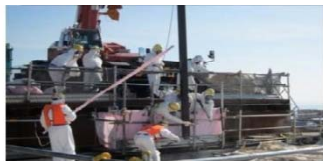
4号機使用済燃料プール内の未使用燃料の試験取出し作業の様子(平成24年7月)
