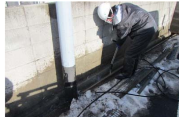
●側溝の汚泥の除去 (提供)福島市
