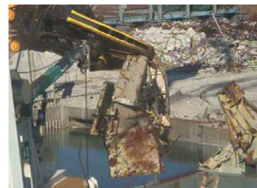
【3号機使用済燃料プールの瓦礫撤去】
