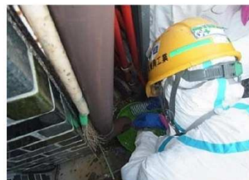
雨樋(縦樋): 高圧水洗浄、吸引
