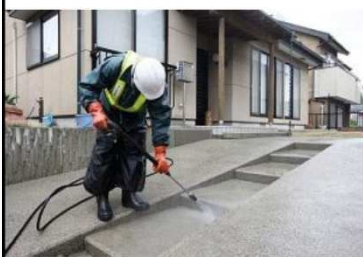
コンクリート土間: 高圧水洗浄
