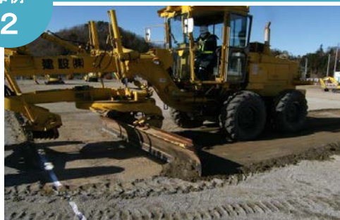
●校庭表土の削り取り
