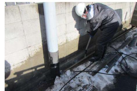
●側溝の汚泥の除去
