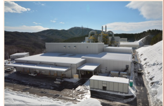
飯舘村蕨平地区の仮設焼却施設 (平成28年1月)
