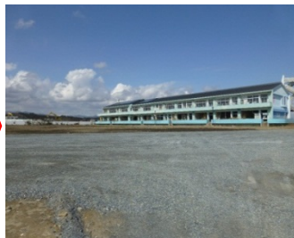
撤去後(平成27年3月)
