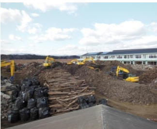
撤去前(平成26年1月)
