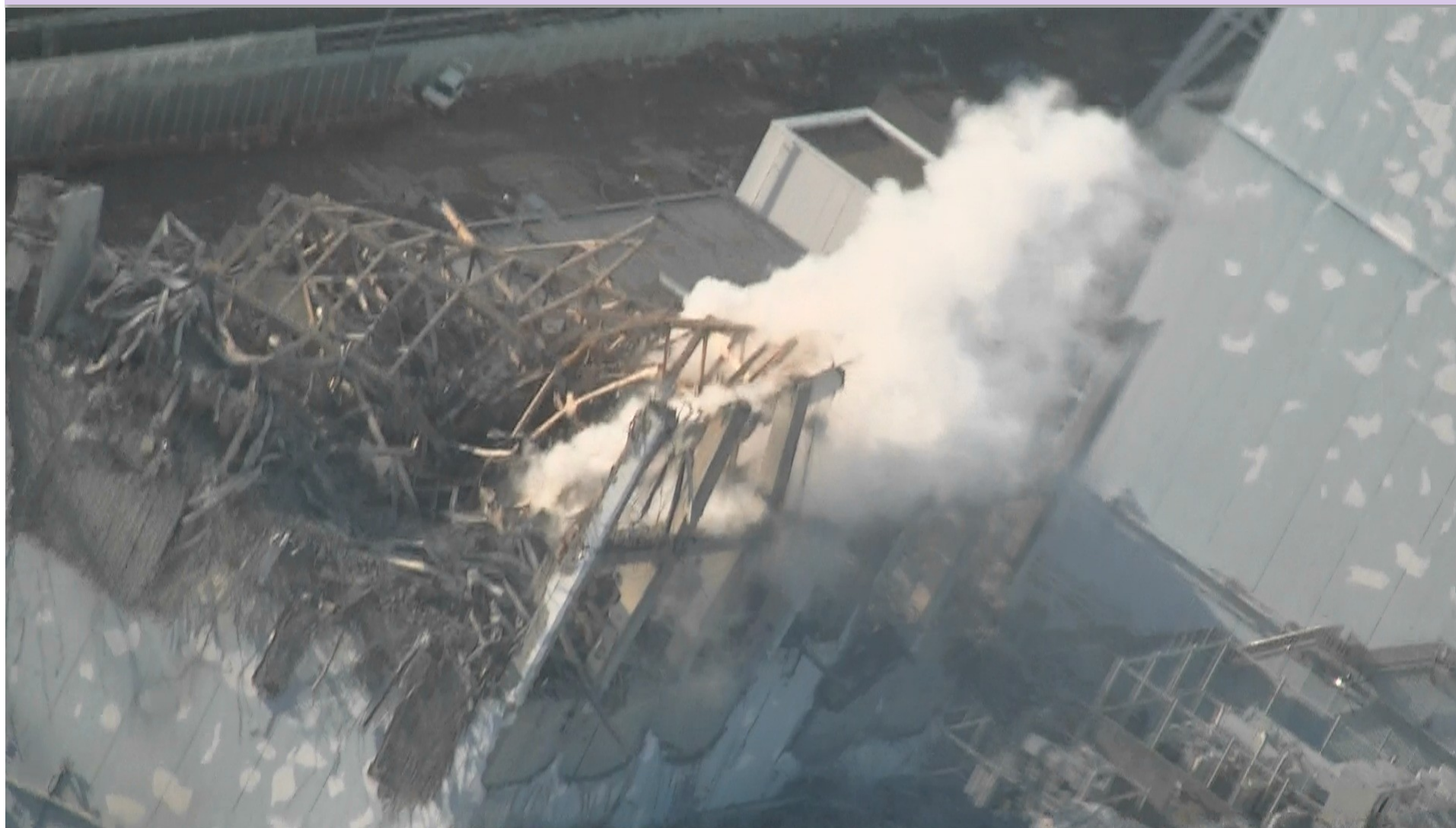
東京電力福島第一原子力発電所3、4号機（空撮）
