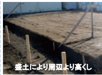
盛土により周辺より高くし
