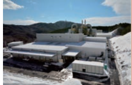
飯館村蔵平地区の仮設焼却施設 (平成28年1月)
