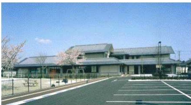
岩沼市総合福祉センター全景(里の杜サポートセンターが入っている施設)
