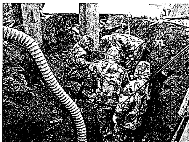
試掘の作業状況
