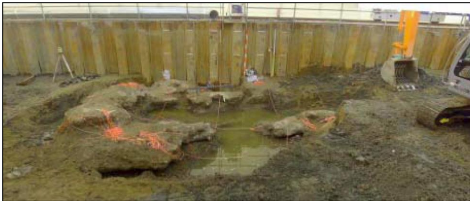
汚染源掘削調査により発見されたコンクリート様の塊（平成 17 年 1 月 27 日）
