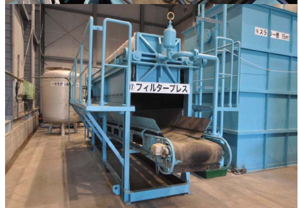
沈降分離槽(写真上段)。ここで発生するスラリー化した沈殿物は、フィルタープレス(写真下段)へ送られ脱水が行われる。
