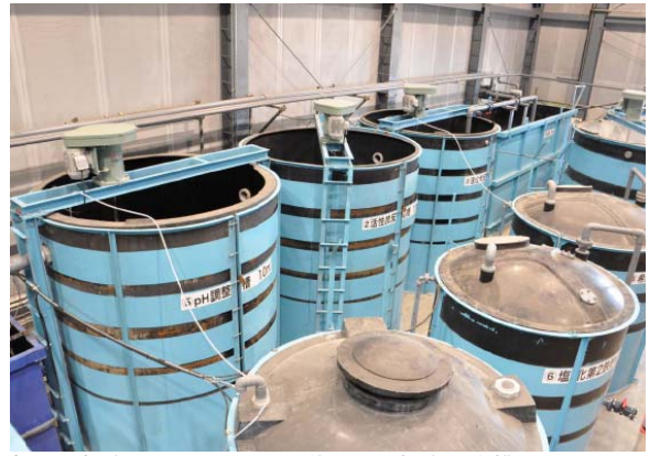
粉末活性炭により DPAA を吸着する活性炭反応槽。A 地区の原水濃度が低くなった場合には、活性炭吸着塔のみの運用も考慮し、フレキシブルな対応も可能なセッティングとしている。
