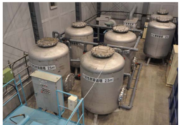
3 連直列の活性炭吸着塔。定期的にローテーションを行い、活性炭による有効な吸着ができる運用を考慮している。
