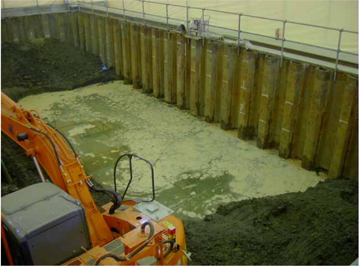
図1 掘削状況（中心部を水面下 GL-4m まで掘削）
