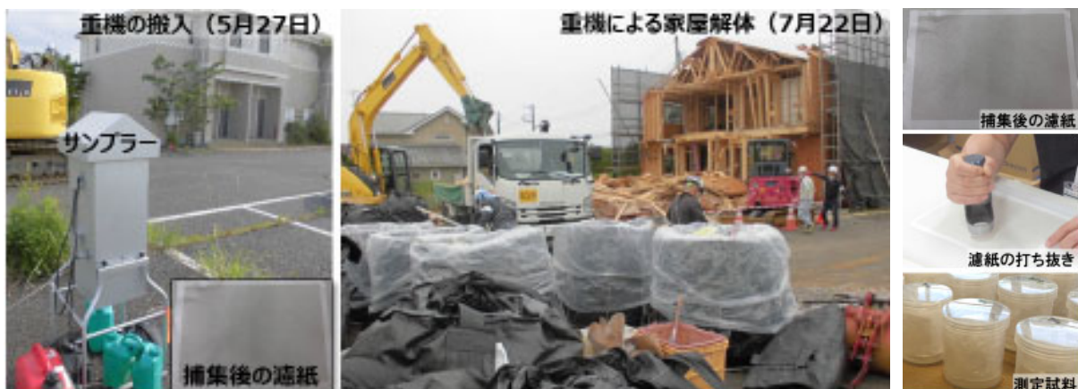
図II-6 解体作業及び大気浮遊塵の捕集・前処理の様子
