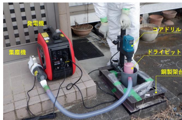
写真 2 コンクリートコア採取作業
