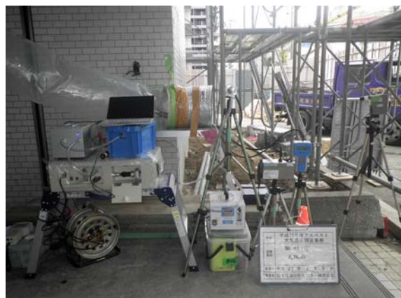
調査地点②(集じん機排気口)
