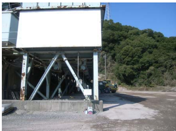
調査地点①(破砕機付近)
