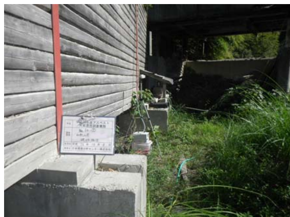
調査地点②(破碎施設敷地境界)
