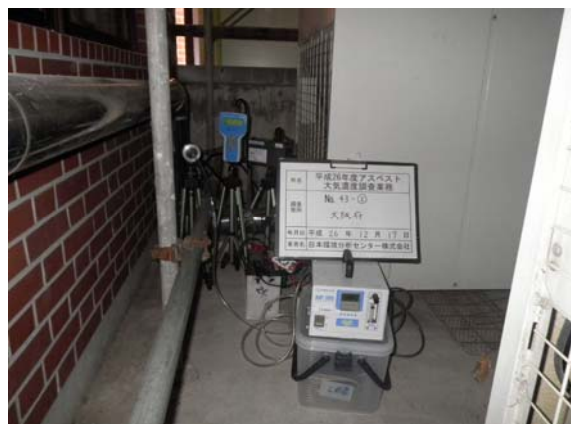
調査地点②(集じん機排気口)
