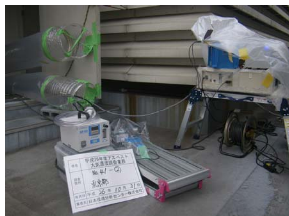
調査地点②(集じん機排気口)
