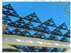
図 8.23 木の葉を模したフラクタル形状の日除け3
