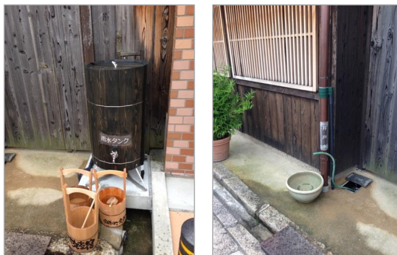
図 5.7 雨水タンク（左）、個人井戸の給水栓（右）
