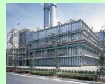
排煙脱硫装置
