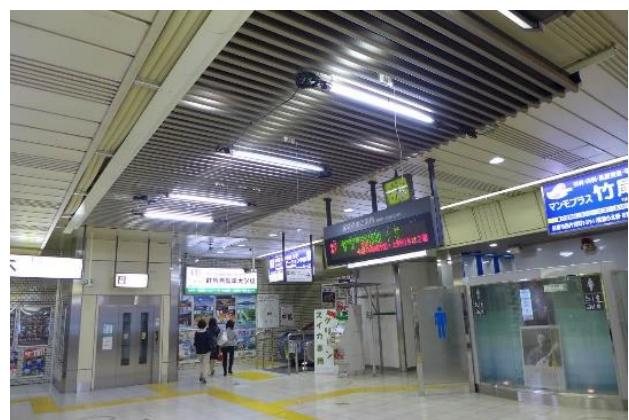
JR 前橋駅コンコースに設置された天井冷房システム
