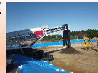
中間貯蔵施設 土壌貯蔵施設
