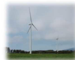
風力発電 (環境省HPより)
