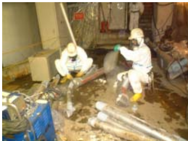
図 4-4-8 配管搬出例(2)
