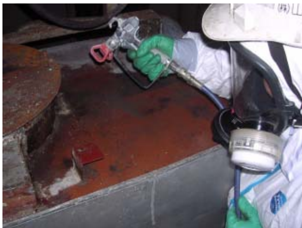
図 4-4-12 薬液散布例
