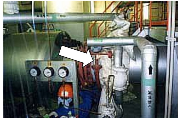
図 4-4-17 蒸気弁保温例
