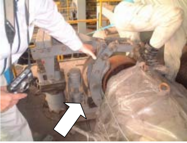
図 4-6-1 ブレーキパッド除去例
