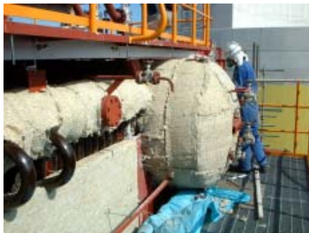
図 4-4-4 ボイラドラム保温例
