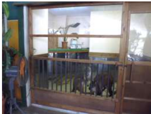
写真2 カンガルーとのふれ合い飼育舎の改修後 （臭気漏れ対策のため、開放面を小さくした）
