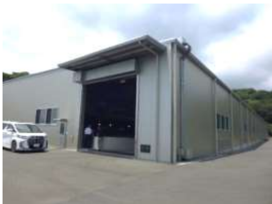
写真1 屋内型最終処分場の入口と外観
