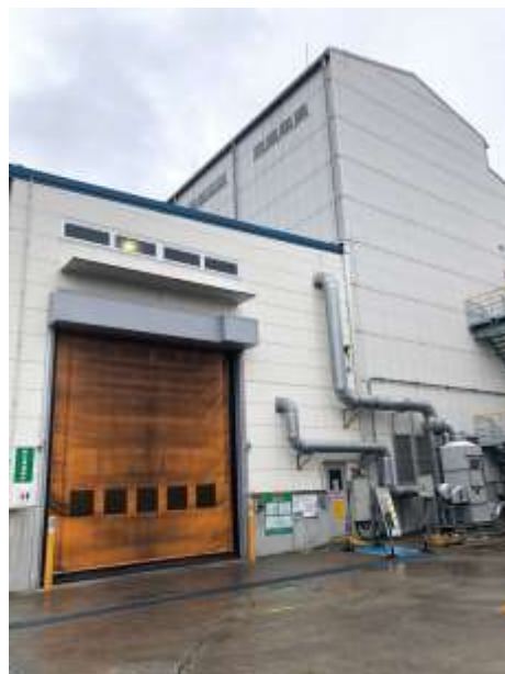
写真2 汚泥ピット前室(左半分)とスクラパー(右下)
