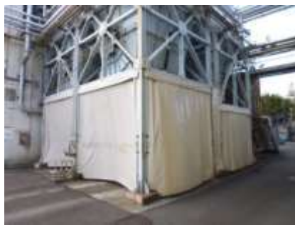
写真1 活性炭フィルター 写真2 汚泥ホッパーとカーテン (左: 内側、右: 外側)
