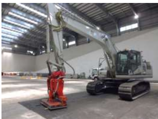
写真5 転圧をかける特注の重機
