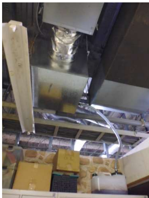
写真3 混合チャンバーに芳香剤を噴霧 （右下のポリタンクに芳香剤を充填）
