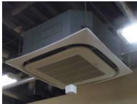
写真6 自然蒸散の消臭剤を吊している (室内空気循環方式のエアコン利用で拡散)
