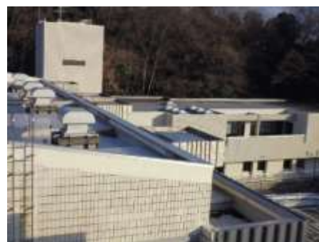
写真1 排出口(四角い金属板が付いている排出口)
