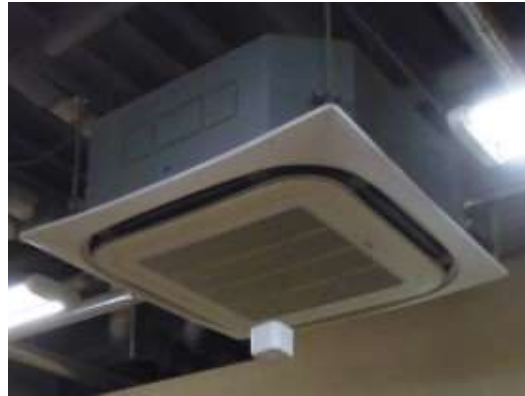
写真6 自然蒸散の消臭剤を吊している (室内空気循環方式のエアコン利用で拡散)
