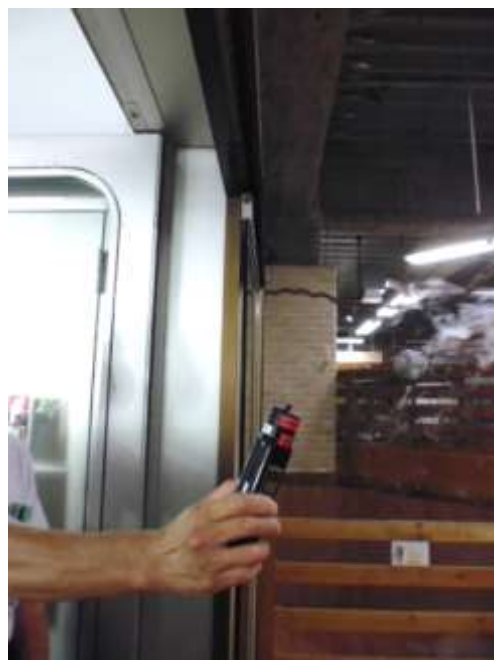
写真4 入口ドア付近で室内が負圧の状況 （左側が店舗外、右側が店舗内。煙が右上）
