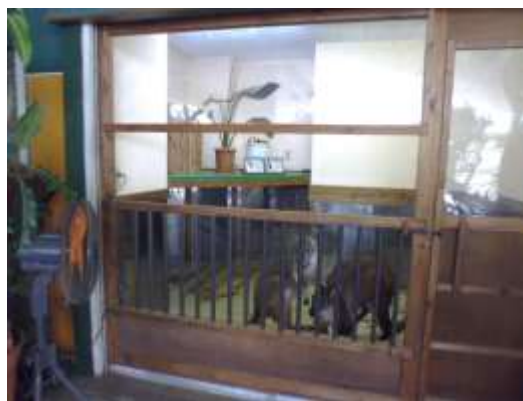
写真2 カンガルーとのふれ合い飼育舎の改修後 （臭気漏れ対策のため、開放面を小さくした）
