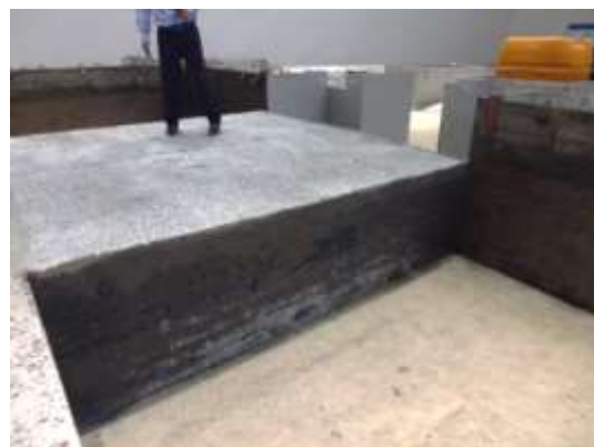
写真6 焼却灰を圧縮硬化したブロック (ブロック：3m×3m×深さ0.8m)
