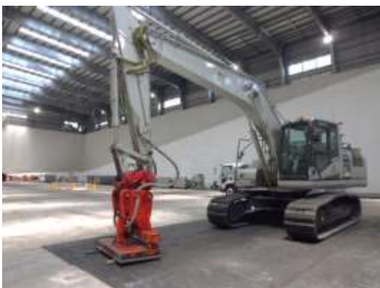
写真5 転圧をかける特注の重機
