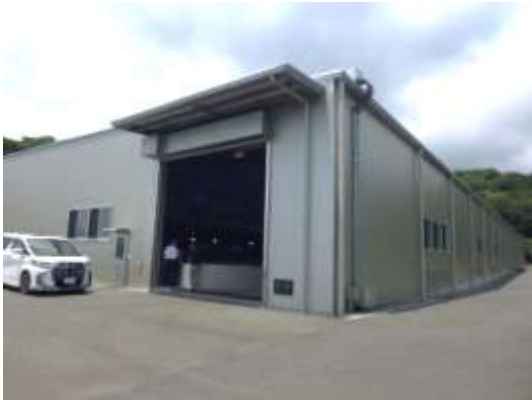
写真1 屋内型最終処分場の入口と外観
