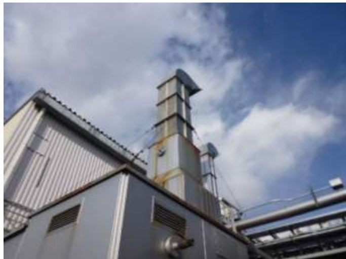
写真2 触媒燃焼脱臭の最終排気口
