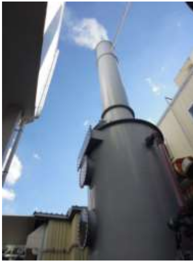
写真1 オゾン水を用いたスクラバー
