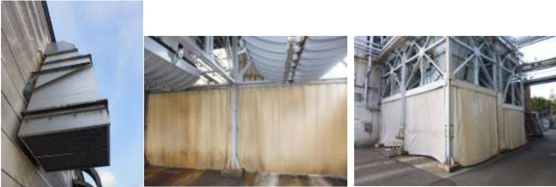
写真1 活性炭フィルター 写真2 汚泥ホッパーとカーテン（左：内側、右：外側）
