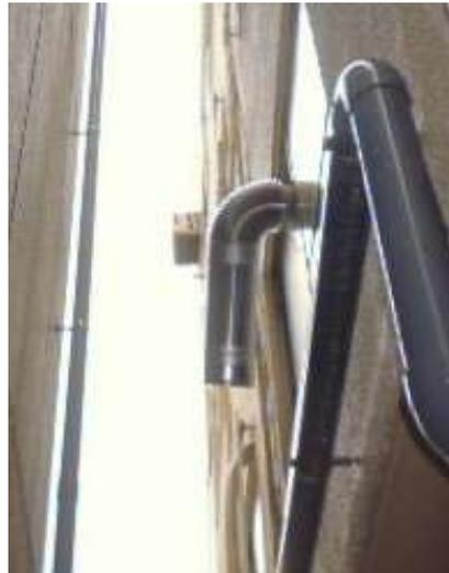
写真2 最終排気口 (2階窓から排気)
