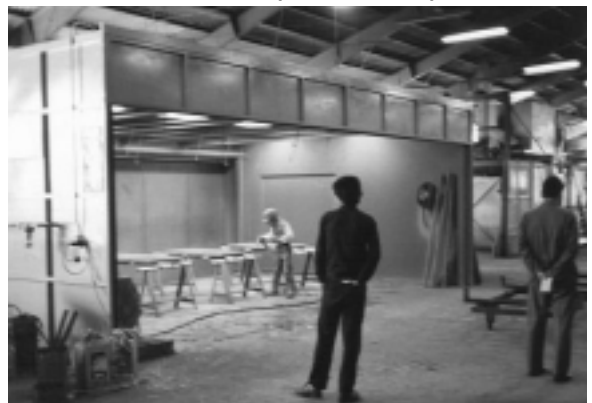
写真3 水洗ブース(改造工事前)
