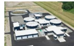
バイオマスプラント
