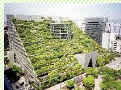
屋上緑化 (暑熱対策・景観)
